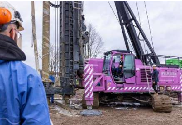
Start van bouw appartementen complex Beemdenborg in Hoensbroek
